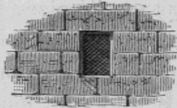
Fig. 132. — Barbacane ou ventouse fermée par un grillage.
