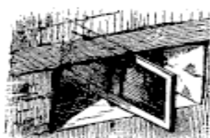
FIG. 69. — Fenêtre tournant autour d'un axe central et vertical pour une porcherie.
