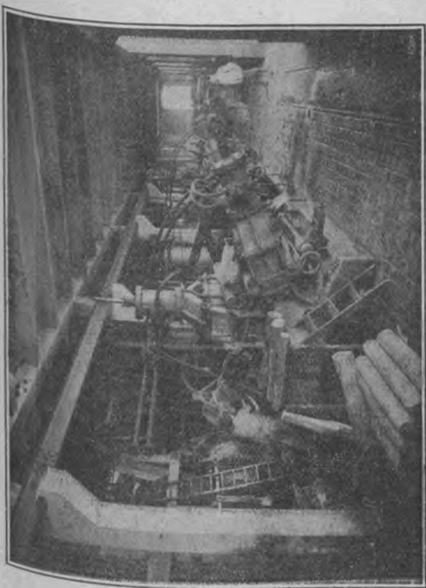
Fabrication de la pâte, le défibrage (Bergès).
