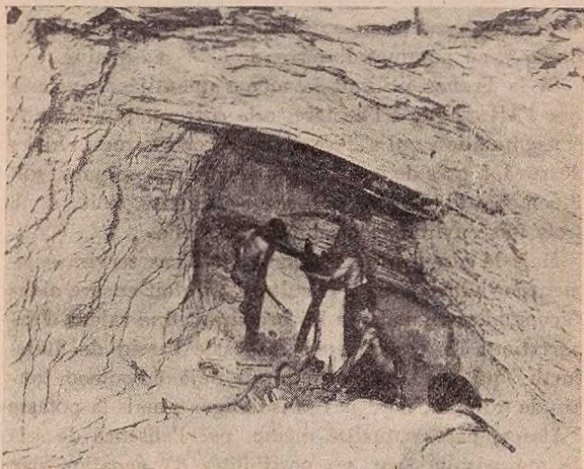
Travail à la haveuse dans une mine de potasse
