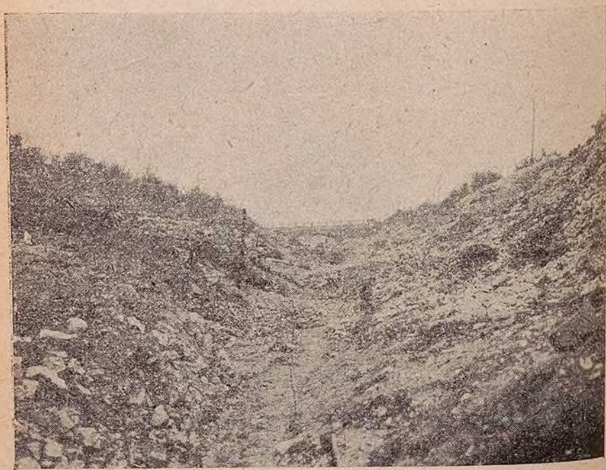
Tranchée de la ligne d'Arras à Lens.
