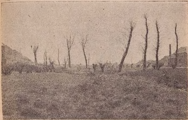
Emplacement du viaduc de Saint-Bénin.
