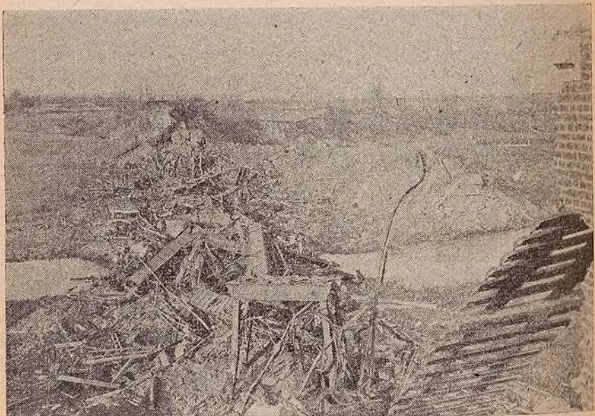
Les décombres du viaduc d'Onis. (Et le viaduc reconstruit le 10 décembre 1919).
