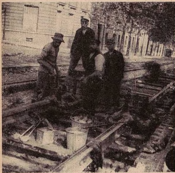
Aluminothermie. — Soudure des rails.
