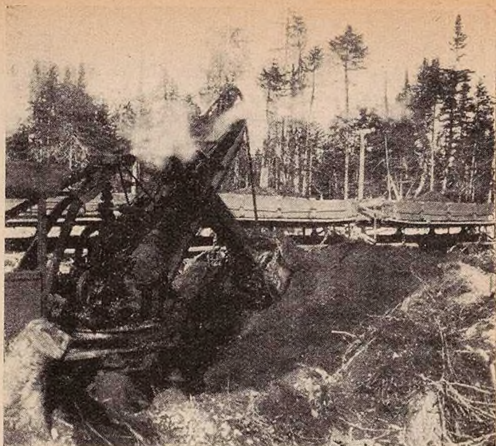
FIG. 16. — CHARGEMENT DU BALLAST.
