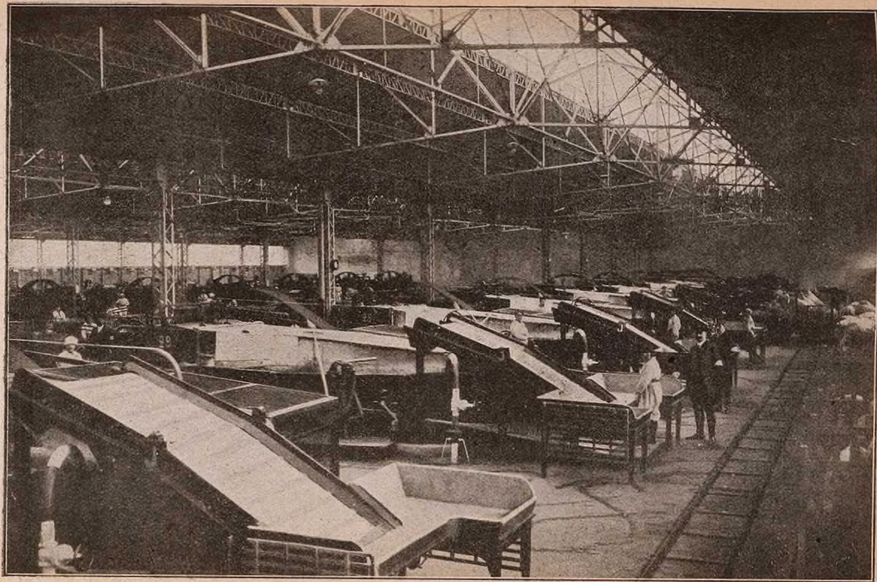
FIG. 6. — PILAGE DU COTON-POUDRE.
