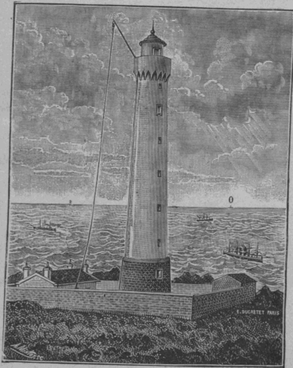
Fig 33. — Le mât et le fil collecto-radiateur employés par M. Tissot, nettes, d'employer un cylindre tournant beaucoup plus rapidement.
