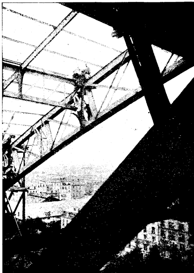
FIG. 198. — Assemblage des pannes sur les grandes Fermes. Système Fives-Lille.
