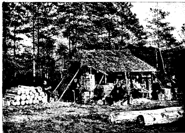
FIG. 397. — Atelier des fendeurs débitant les bardeaux pour la couverture du Pavillon.
