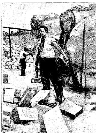
FIG. 667. — Carrière des Maréchaux. — Maitre Carrier au travail. (Opération du dédoubleage d'un bloc.)
