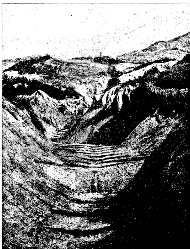
FIG. 462. — Torrent de la Vallette (Basses-Alpes) (1,506 mètr. d'altitude). Correction par des barrages et des clayonnages combinés.
