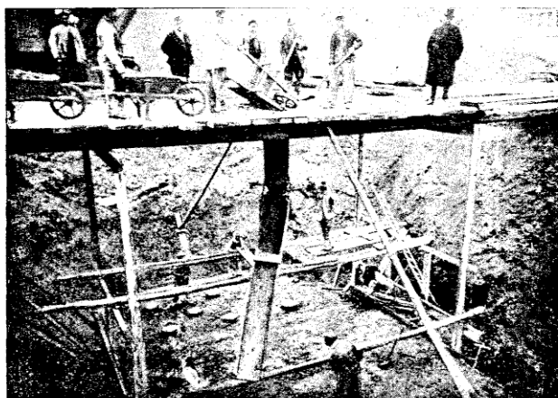
FIG. 181. — Fondations. Coulage du béton.
