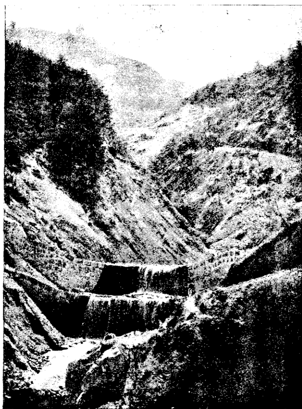
Fig. 463. — Le Torrent de Riou-Chanal (Basses-Alpes) (1,600 mètres d'altitude). Barrages en gradins. Système Bectón.
