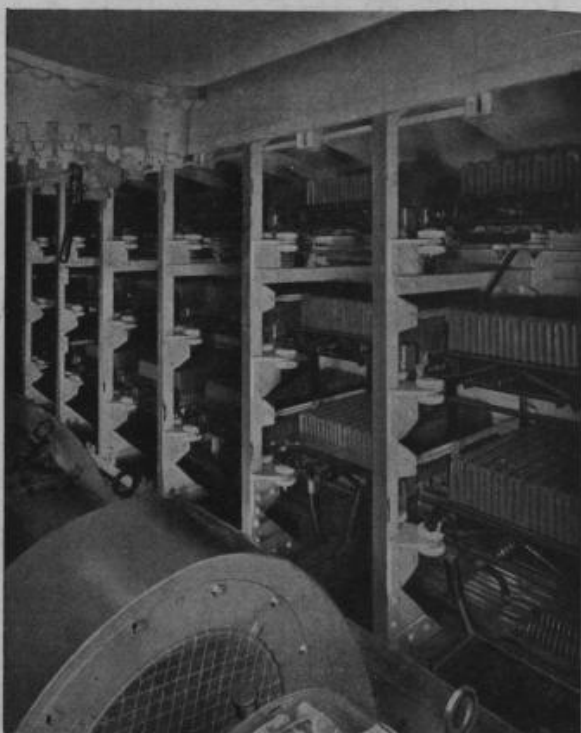
Fig. 22. — L'un des compartiments des résistances (à la partie inférieure, les résistances de shuntage (en spirale).
