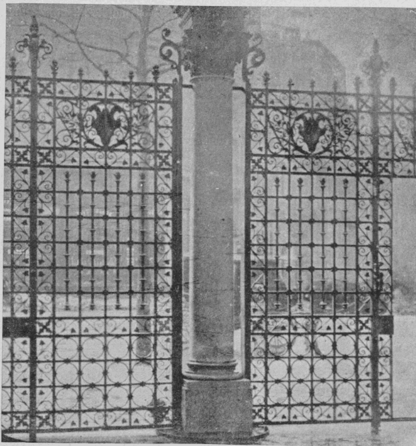
Grilles doubles en fer forgé. Hôtels de MM. A. et P. Mirabaud, avenue de Villiers. 1880.
