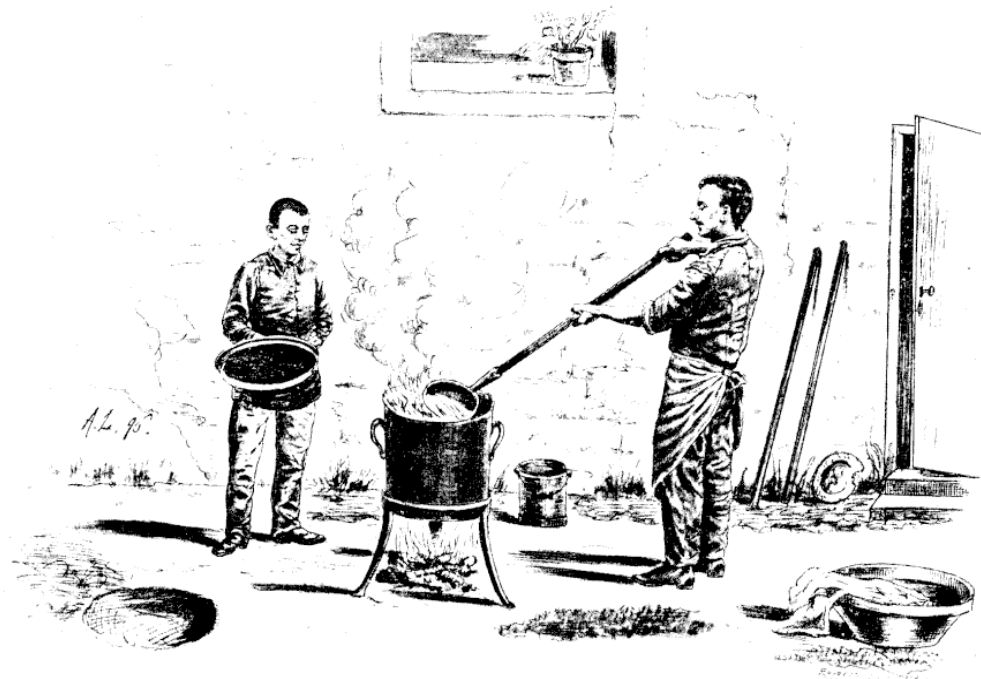
Fabrication du vernis à la flamme.
