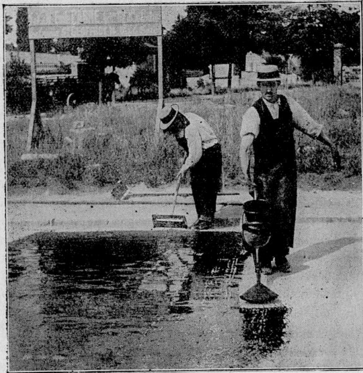
Fig. 1. — Arrosoir avec bec spécial pour le répandage du goudron.
