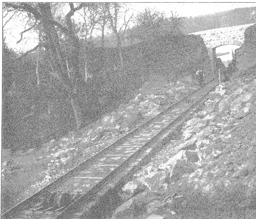
Vevey - Pélerin. Infrastructure terminée, joints de l'assise supérieure en mortier de ciment coulé. Fig. 22.
