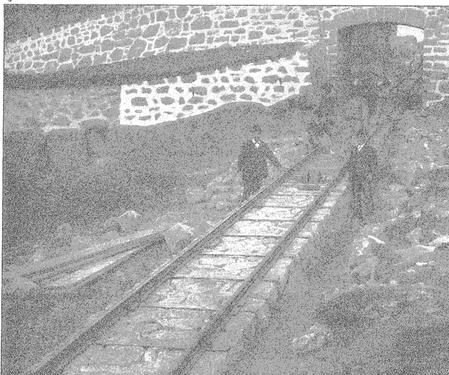
Vevey - Pélerin. Infrastructure terminée, joints de l'assise supérieure en mortier de ciment coulé. Fig. 22.
