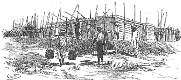
Bâtiments en construction, à Hanoï.
