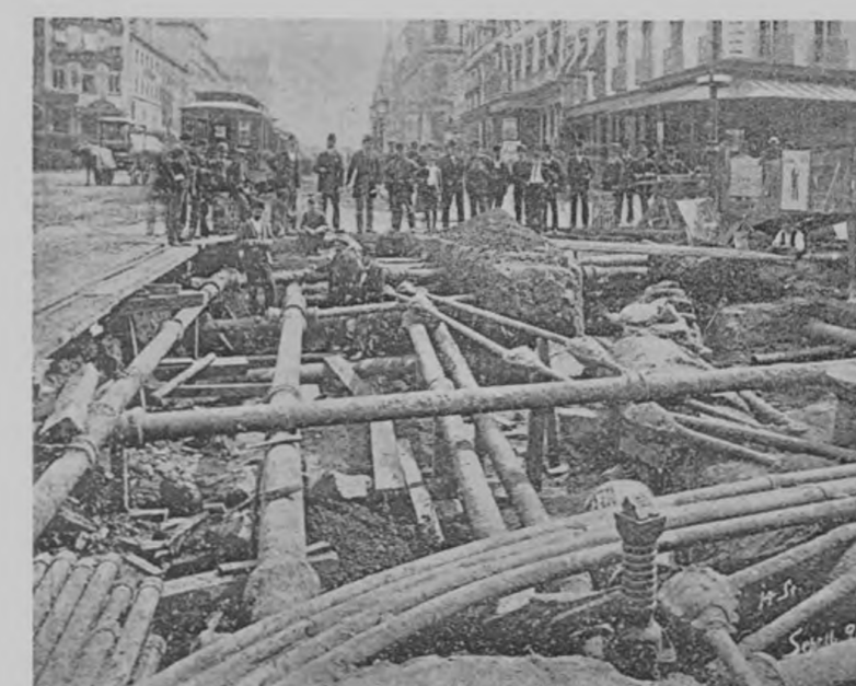
FIG. 6. — VUE DES CONDUITES RENCONTRÉES SOUS LE PAVAGE DANS LA FOUILLE NÉCESSITÉE PAR LA POSE DE LA VOIE
