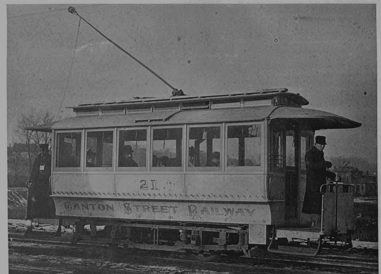
FIG. 4. — VOITURE ÉLECTRIQUE MUNIE DE DEUX MOTEURS DE 15 CHEVAUX WESTINGHOUSE
