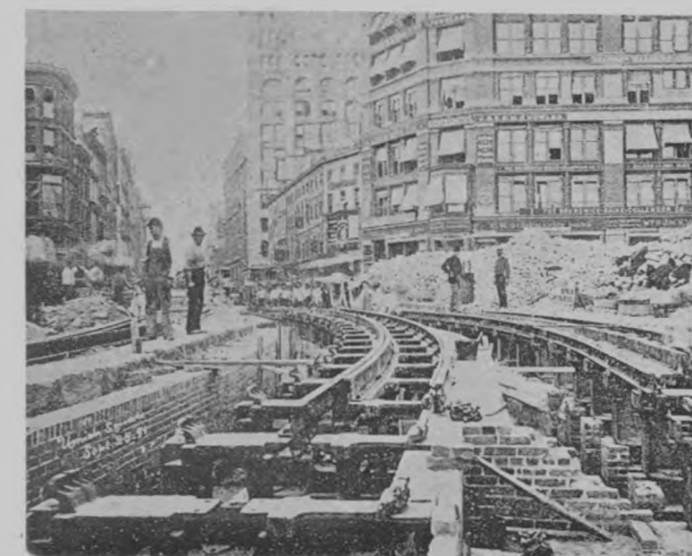
FIG. 3. — POSE DE LA VOIE EN COURBE AVEC GALERIE DE VISITE
