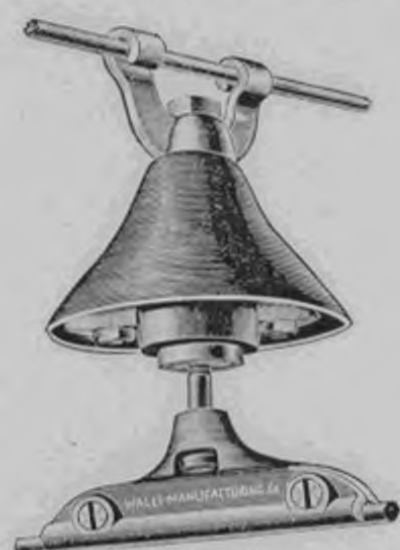
FIG. 8. SUPPORT ISOLANT SOUS CABLE
