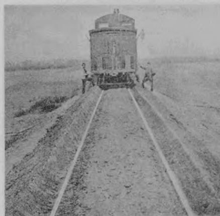
RÉPARTITION DU BALLAST APRÈS LE PASSAGE DU TRAIN
