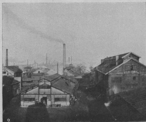
Fig. 7. — Usine Poirrier : ateliers divers.
