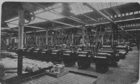
Fig. 46. — Usine de MM. Hannart frères : salle de foulage.
