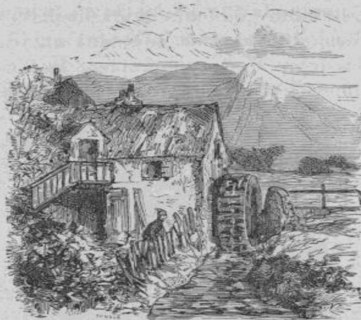
Une chute d'eau fait tourner une roue, celle-ci transmet son mouvement à des roues dentées qui, à leur
