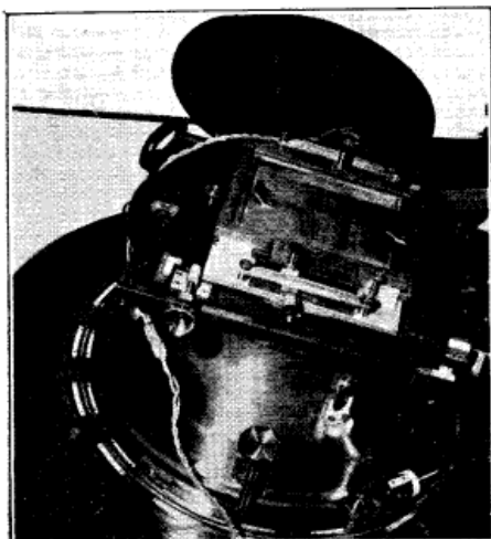
Fig. II. — Chassis avec oculaires latéraux. Grand coude de l'Observatoire de Paris.
