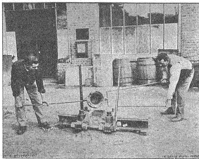
Fig. 864. — Soudure des rails par le procédé Goldschmidt
