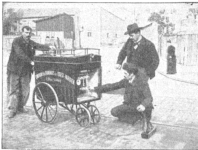
Fig. 734. — Essai des plots Diatto.
