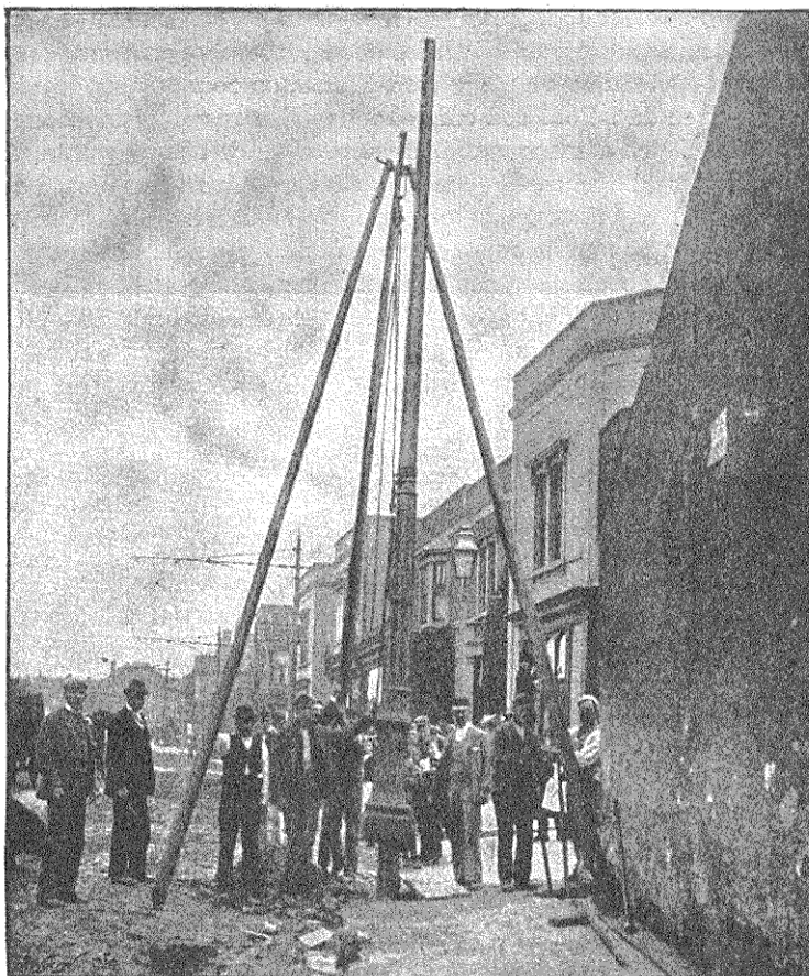
Fig. 270. — Mise en place d'un poteau avec une chèvre-trepiéd.
