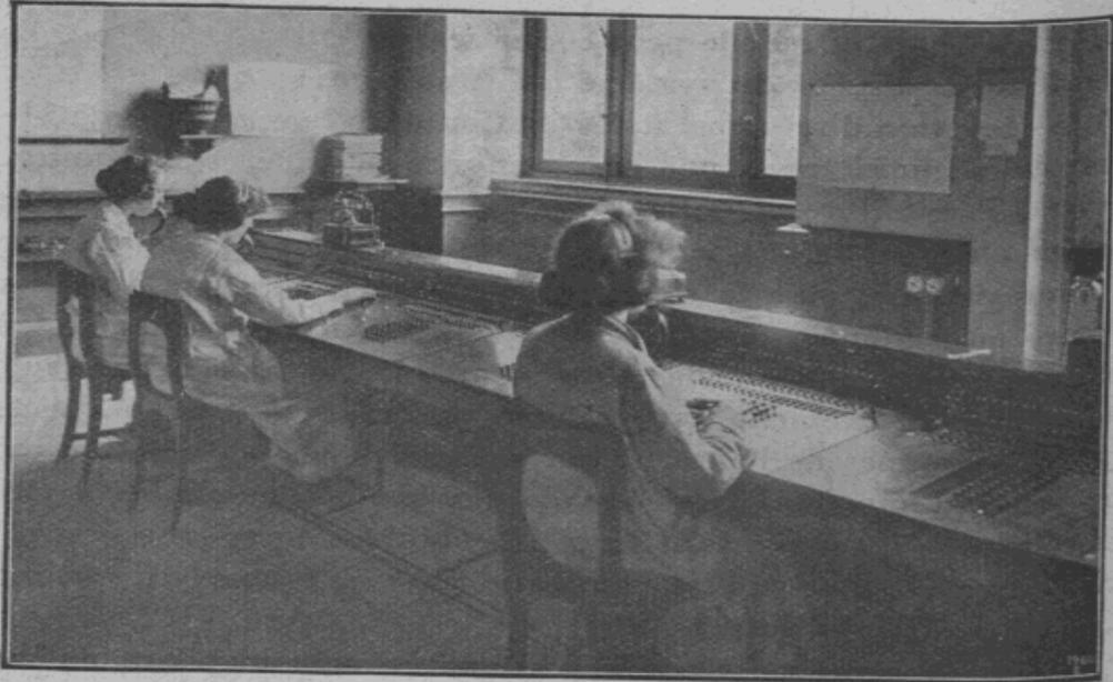
Fig. 160. — Positions semi-automatiques B (réseau de Bruxelles).
