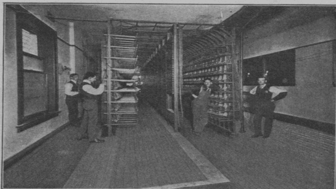
Fig. 198. — Vue des répartiteurs et du bâti de relais du bureau central de Los Angeles
