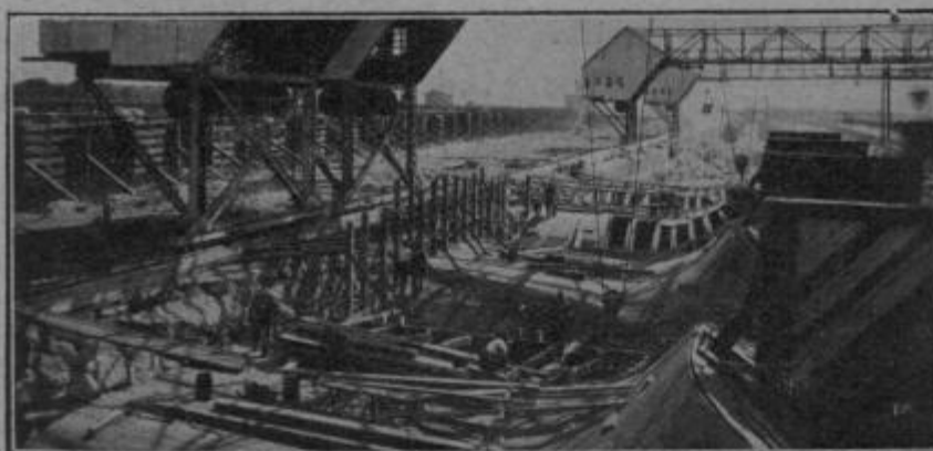
FIG. 805. — Usine de Keokuk. — Les moules des tubes d'aspiration mis en place.
