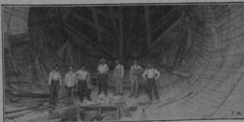
FIG. 806. — Usine de Keokuk. — Vue de l'intérieur d'un tube d'aspiration.
