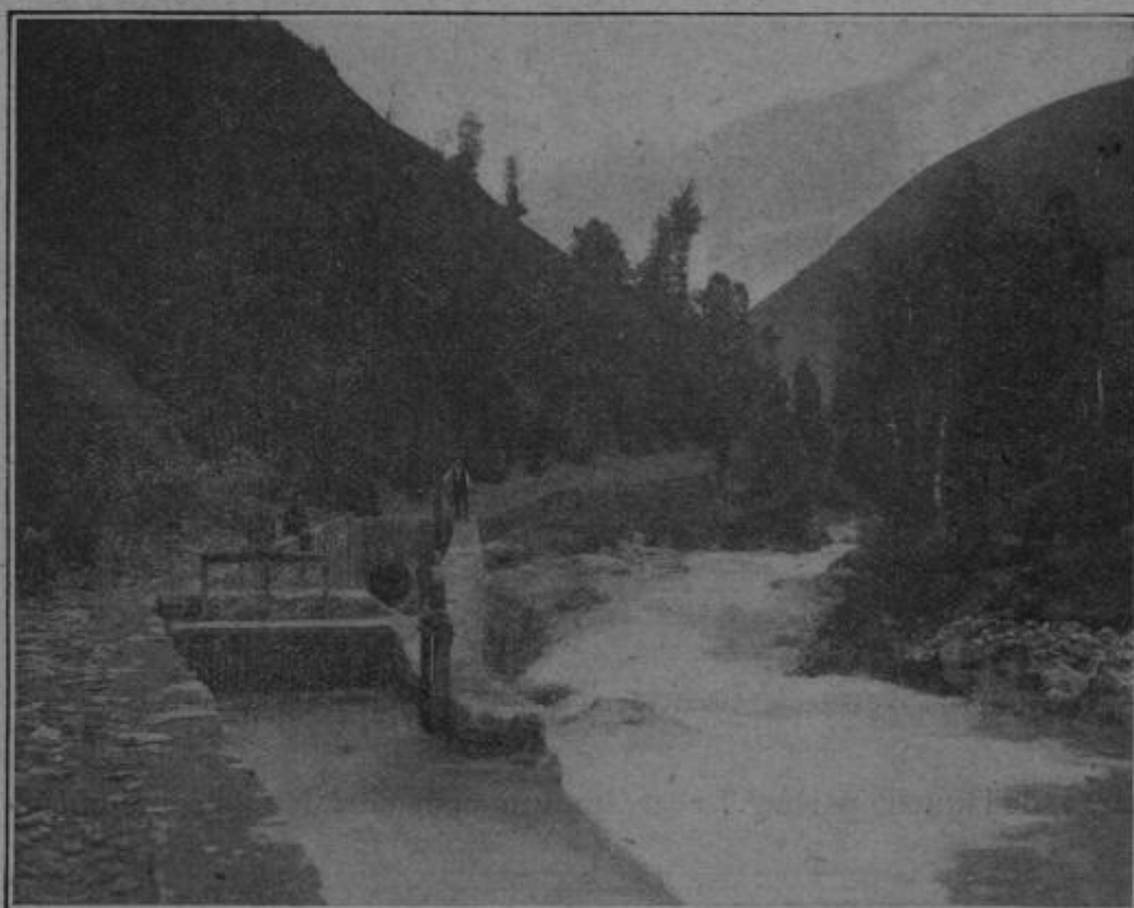
FIG. 970. — Usine d'Auzat. Grille et vanne de commande des canaux d'adduction.
