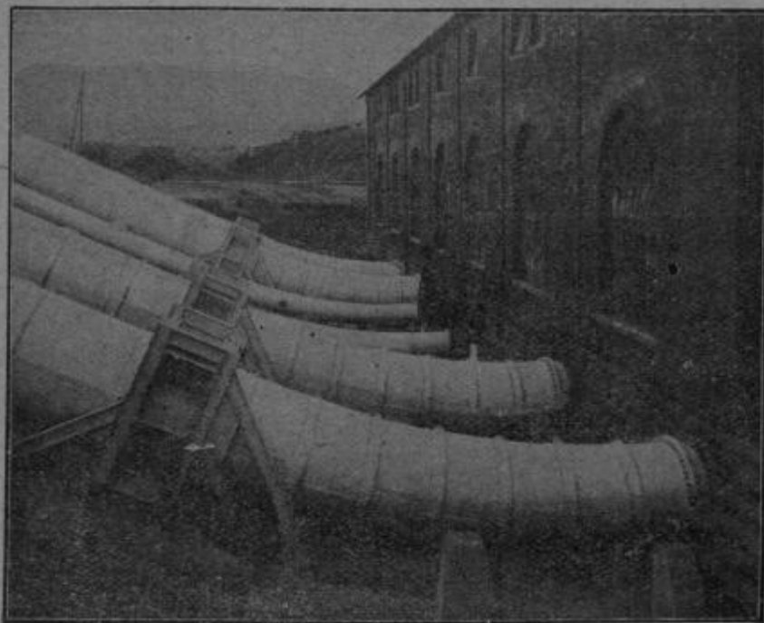
FIG. 876. — Usine de Ventavon. — Entrée des conduites forcées dans l'usine.
