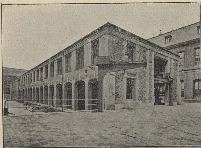
FIG. 1. — Vue d'ensemble du nouveau bâtiment du Laboratoire.
