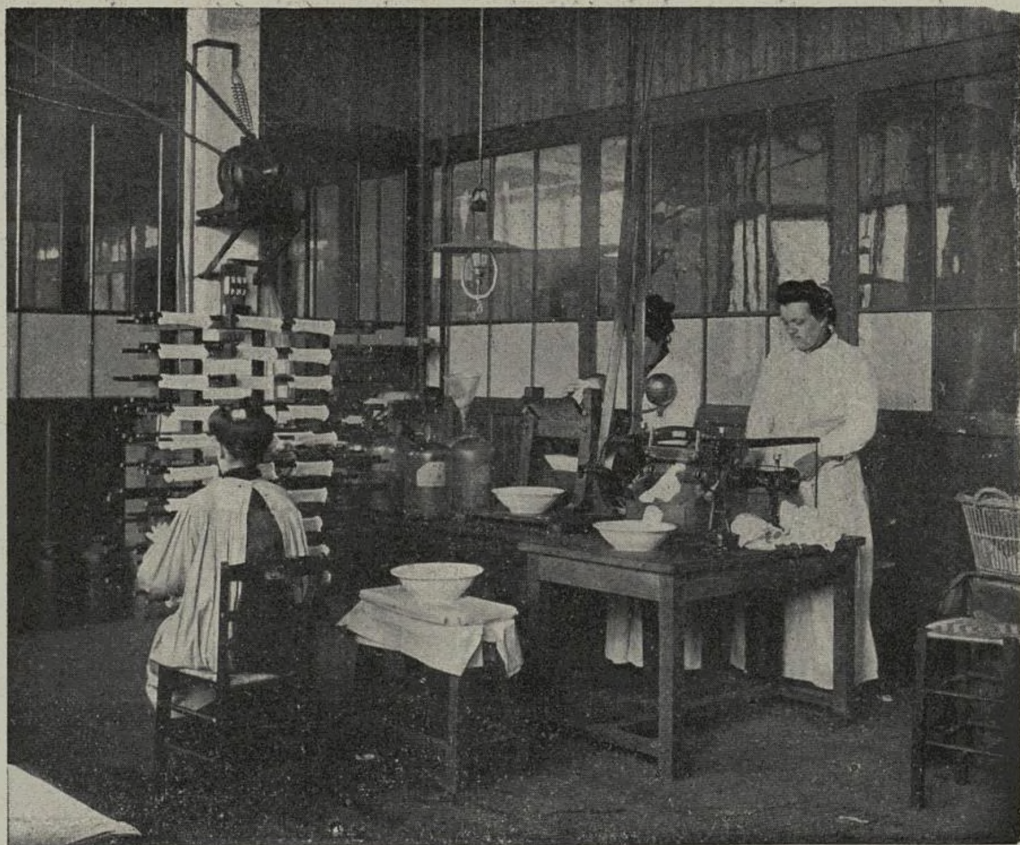
Fig. 12. — Découpage et imprégnation des manchons en ramie. (A droite de la figure, le laminoir, destiné à exprimer le flux lumineux en excès. — A gauche, l'ouvrière étend les manchons imprégnés).
