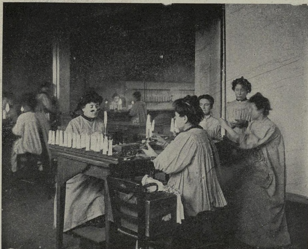
Fig 18. — Brûlage et calcination à la main.
