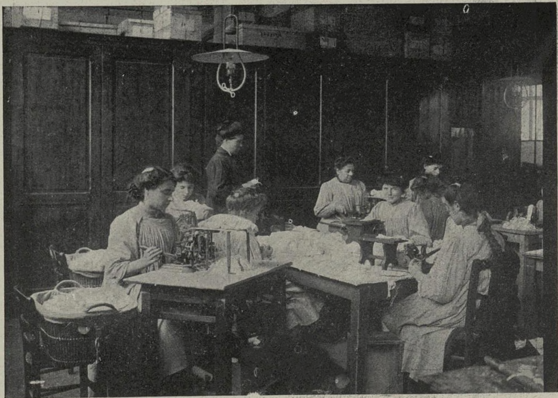
Fig. 14. — Passage du fil d'amiante dans la tête du manchon.
