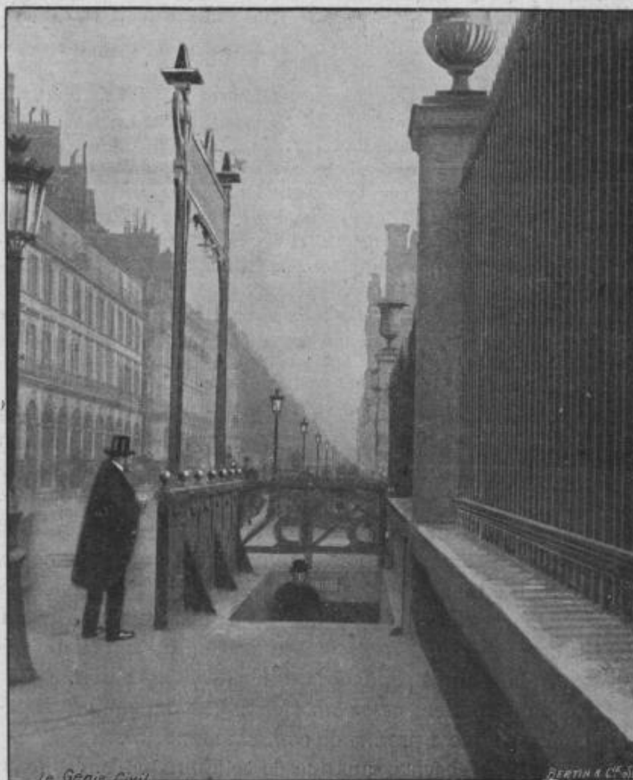
FIG. 79. — Vue de l'entrée de la station des Tuileries (13 février 1901).
