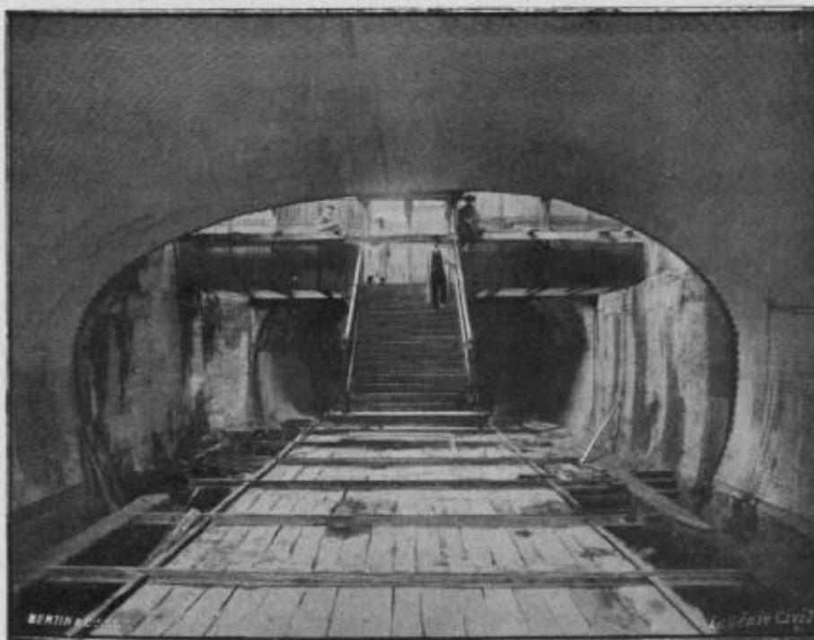
FIG. 16. — Construction des passerelles et escaliers de la station de la Porte Maillot; vue prise le 4 avril 1900.
