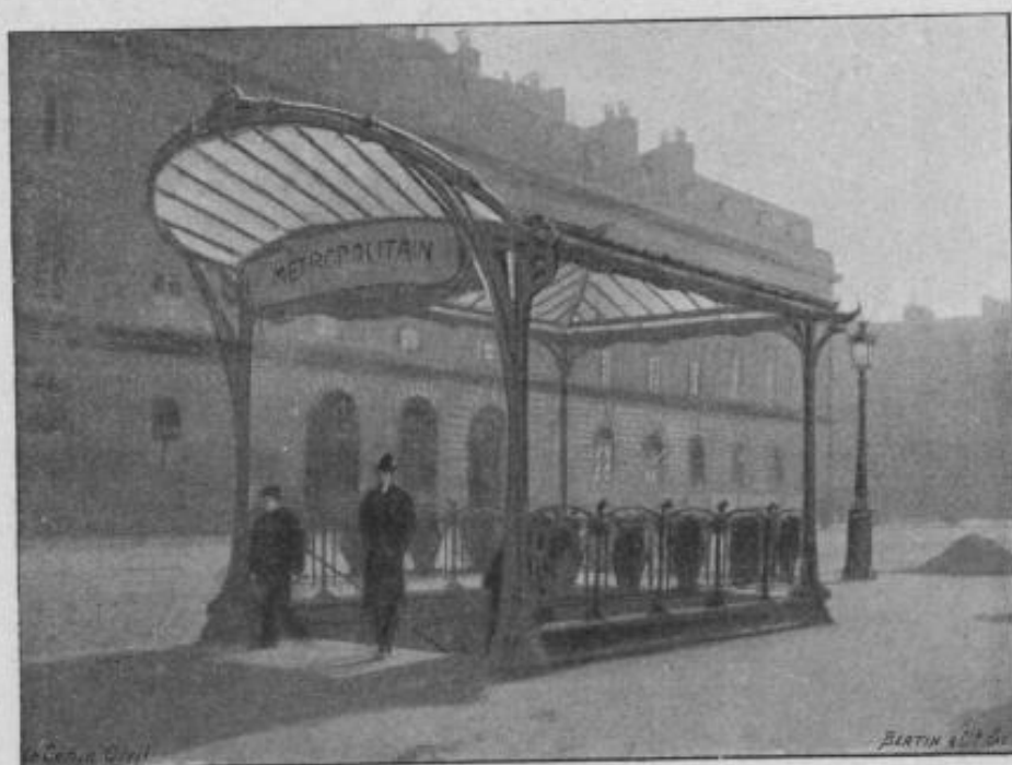
FIG. 77. — Vue de l'entrée de la station de l'Hôtel-de-Ville (13 février 1901).
