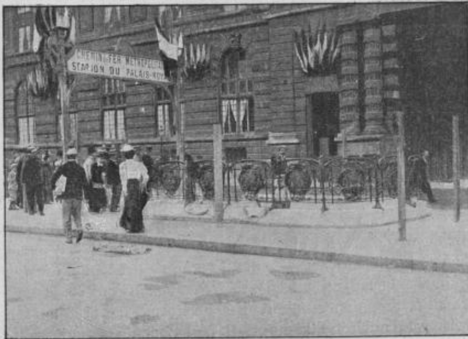
FIG. 76. — Entourage de l'escalier d'accès de la station du Palais-Royal ; vue prise le 16 juillet 1900.
