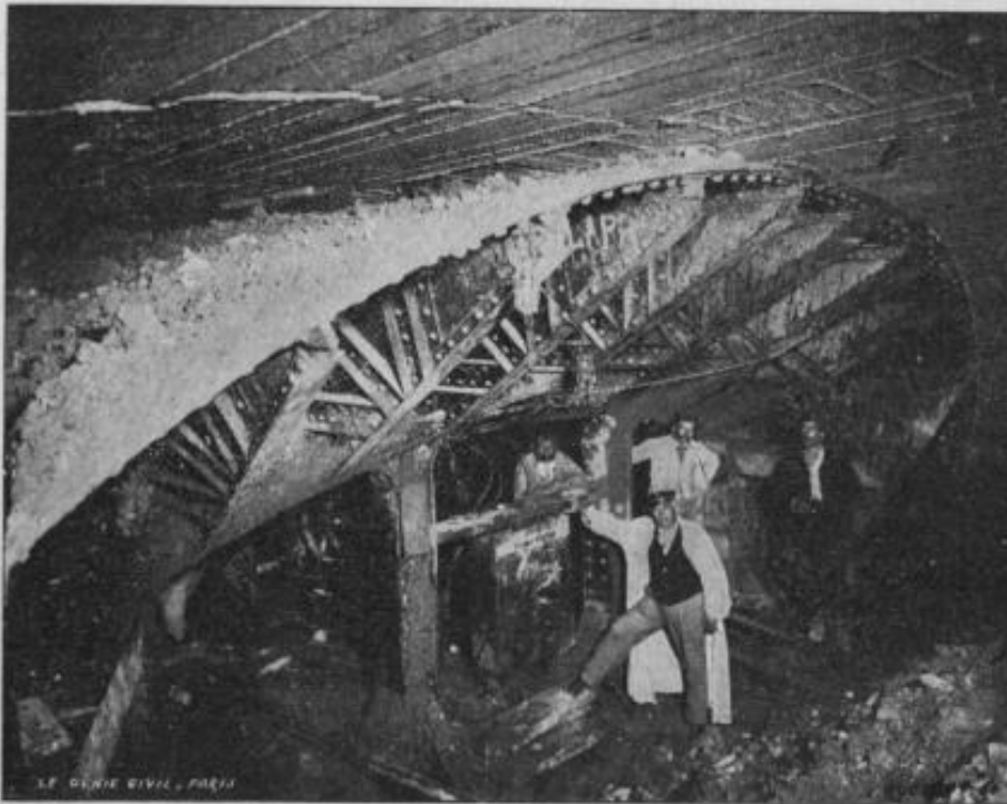
FIG. 38. — Arrivée d'un bouclier dans un lot terminé; vue prise le 5 novembre 1899.
