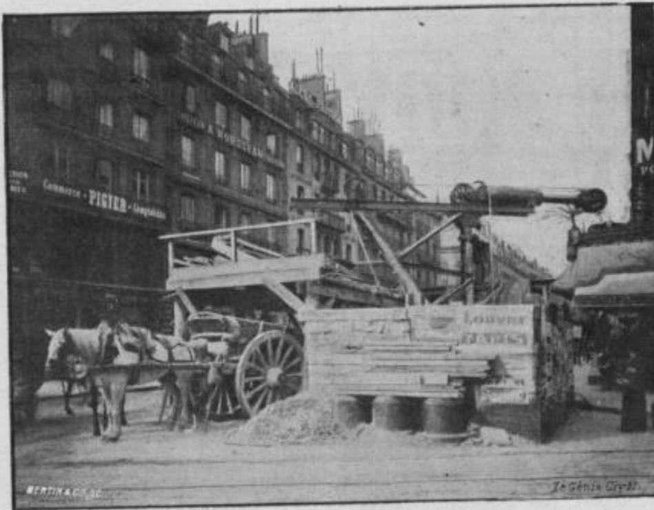
FIG. 33. — Puits d'extraction avec ascenseur hydro-électrique, installé à l'angle de la rue des Halles et de la rue de Rivoli ; vue prise le 13 novembre 1899.
