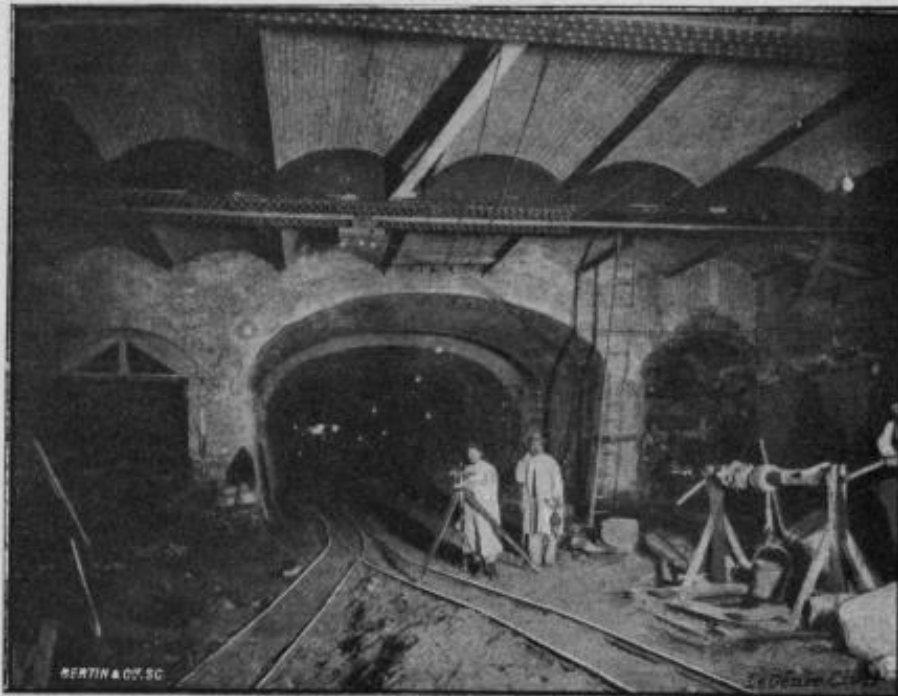
FIG. 17. — Construction de la station de l'Hôtel-de-Ville; vue prise le 11 juillet 1899.
