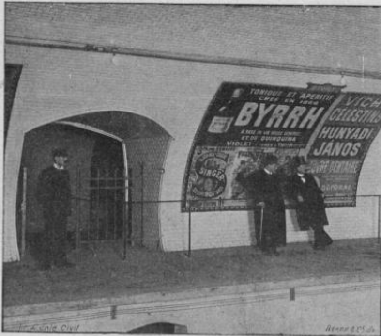
FIG. 70. — Station de l'Étoile (ligne de Vincennes-Porte Maillot) : vue d'une baie de communication avec la station accolée de la ligne Étoile-Trocadéro.
