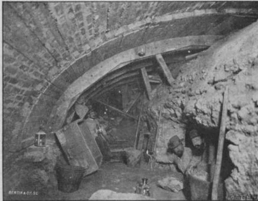
FIG. 39. — Construction de la voûte du Métropolitain par-dessus le collecteur Rivoli.
