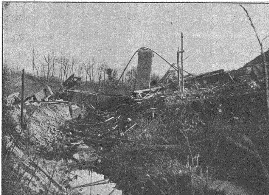
Fig. 71. — Viaduc de Blangy, sur l'Oise, détruit (ligne de Lille à Valenciennes et à Hirson).
