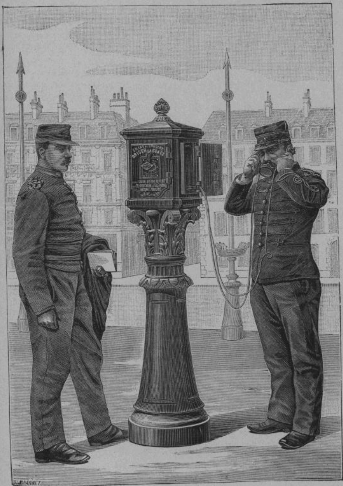
Fig. 383. — Officier de pompiers communiquant avec la caserne, (appareil Digeon).
