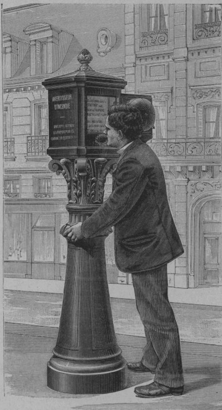
Fig. 382. — Transmission d'un avis de feu par l'avertisseur Digeon.
