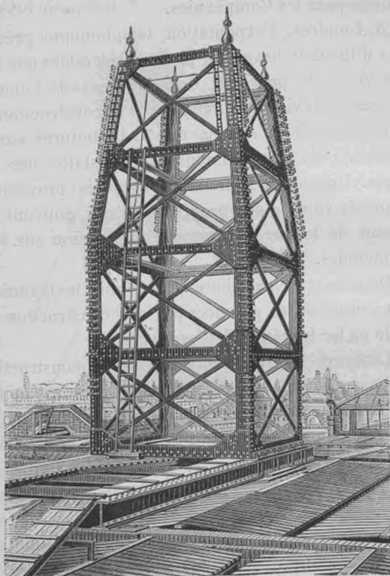
FIG. 125. — Cage disposée pour recevoir de 1.200 à 1.500 fils téléphoniques.
