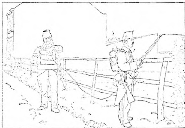
FIG. 66. — Relèvement d'un câble téléphonique.
