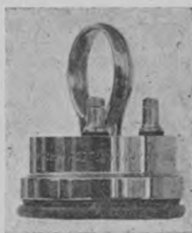
Fig. 18. — Récepteur Ducoussou à anneau.
