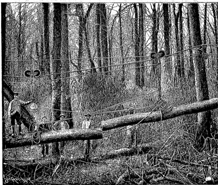
Fig. 1345. — Déblayage d'une coupe par le cableway Lamb (p. 360).
