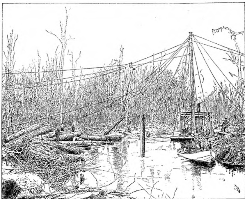
Fig. 758. — Transbordement des arbres en rivière, par le cableway Lidgerwood et Butter.
