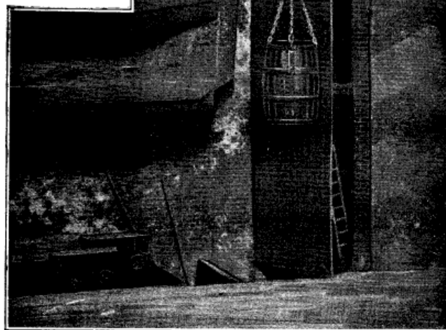
Puits d'extraction en 1822. Diamètre : 2 m ,60. Extraction par tonneaux de 7 hectolitres non guidés, câbles plats en chanvre de 1/8 e ,300.
