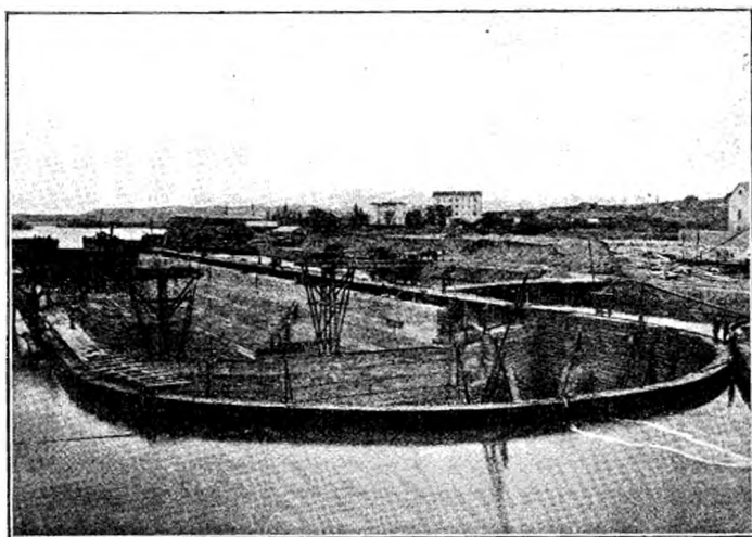
Fig. 44. — Troisième bassin de Missiessy. — Jonction des deux caissons.
