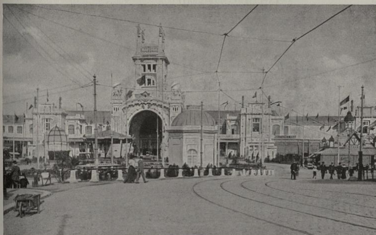
FAÇADE DU HALL DES INDUSTRIES.
