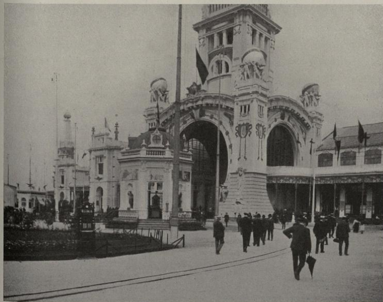
DOME CENTRAL DU HALL DES INDUSTRIES.
