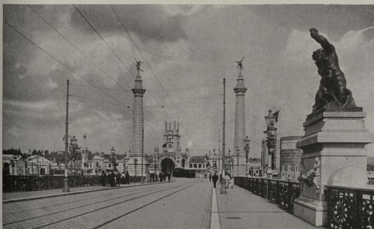
PONT DE FRAGNÉE
