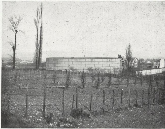
FIG. 31. — Réservoir du mont Valérien.
