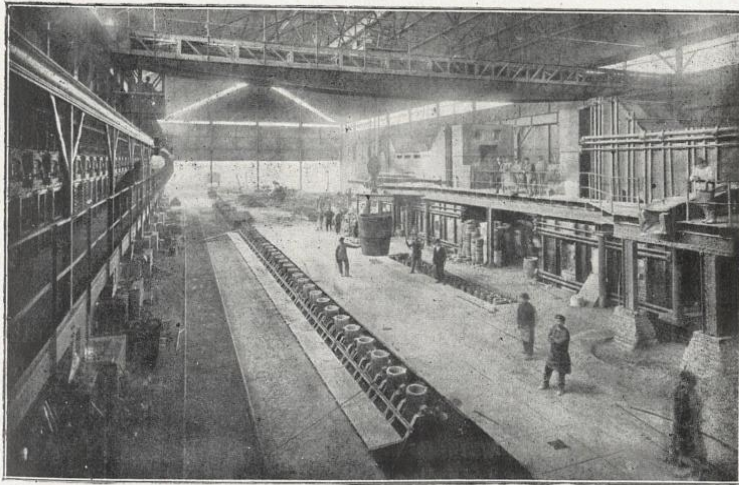
FIG. 13. — Halle de coulage des lingots creux (usine de Louvroil).
