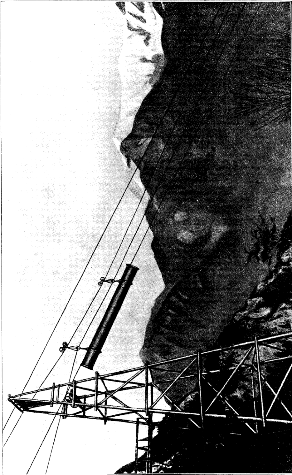
Fig. 170. — Chemin de fer aérien tricâble, système Ceretti et Tanfani.
