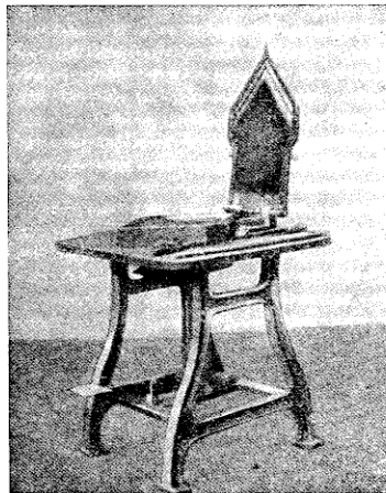
Fig. 181. — Machine à faire les tuiles en ciment.
