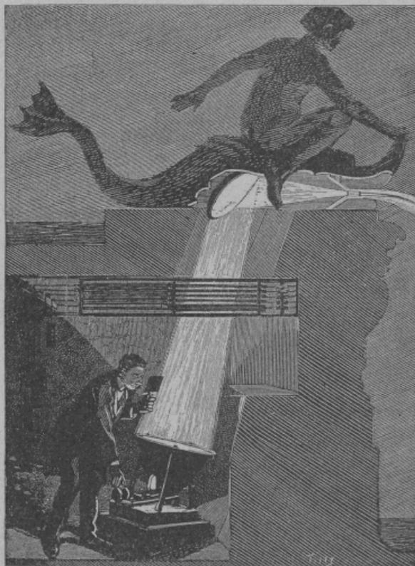
Fig. 50 — Les fontaines lumineuses. Disposition des projecteurs éclairant les jets horizontaux.
