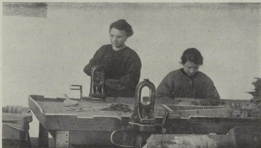
II. — La botteleuse engage la botte dans la presse (deuxième mouvement).
