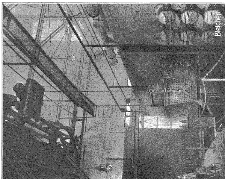
Installation pour l'extinction et le transport du coke, suivant brevet Illig, avec voie suspendue électrique Bleichert. Obtention de coke de la meilleure qualité.
