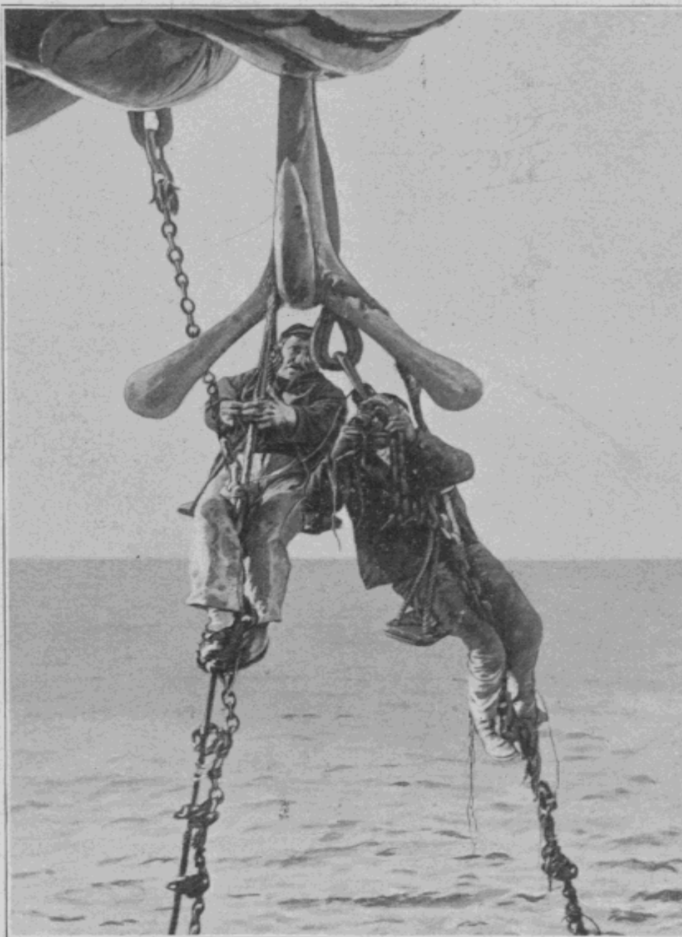
RÉPARATION D'UN CABLE TÉLÉGRAPHIQUE SOUS-MARIN Le câble est saisi par un grappin et ramené à bord.
