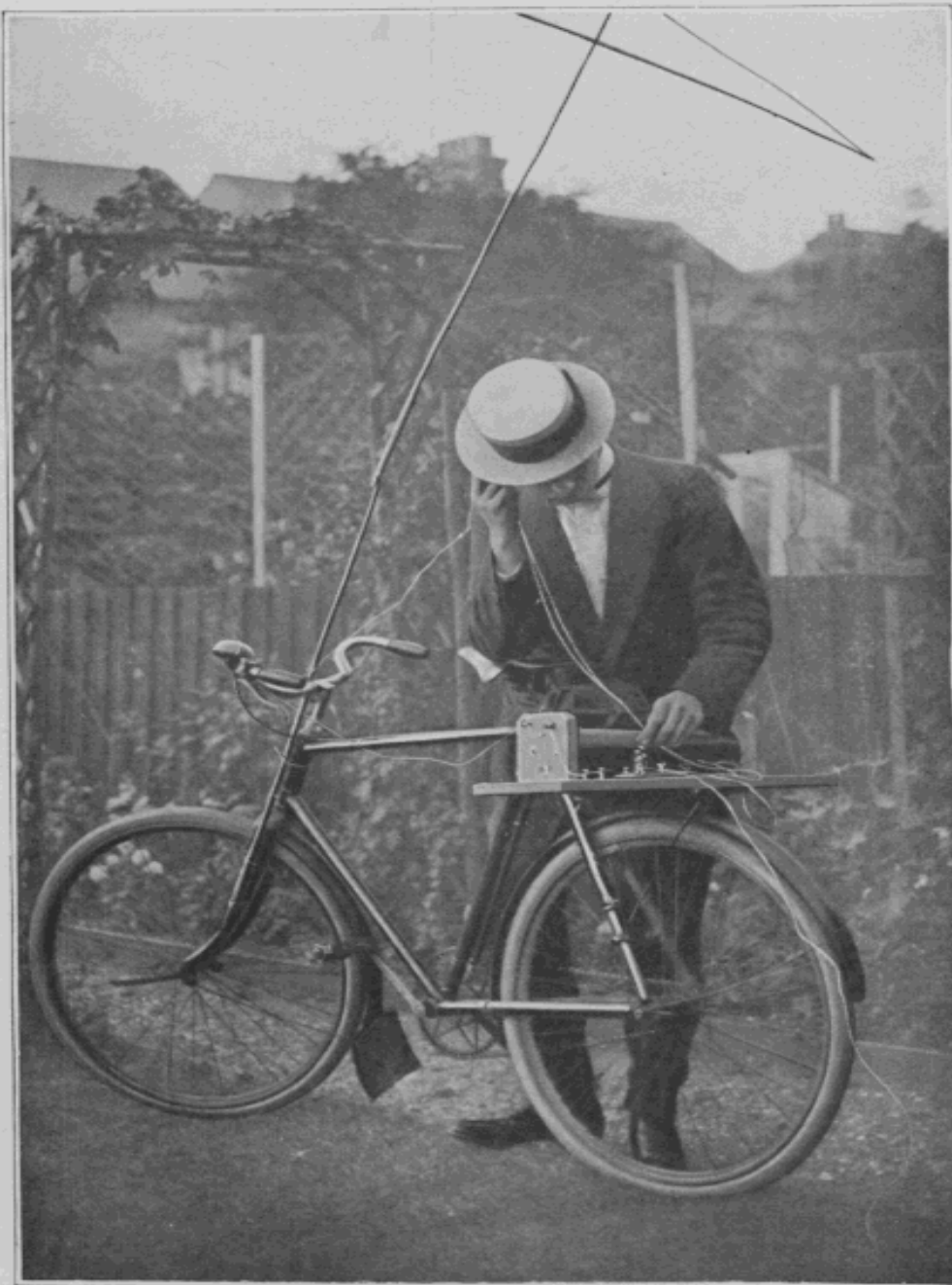
UNE RÉCEPTION IMPROVISÉE La bicyclette porte une tige qui sert d'antenne.
