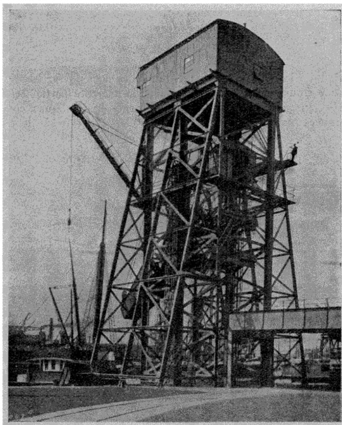
Fig. 2. — Basculeur n° 1 de 32 tonnes. Levée 15 mètres.
