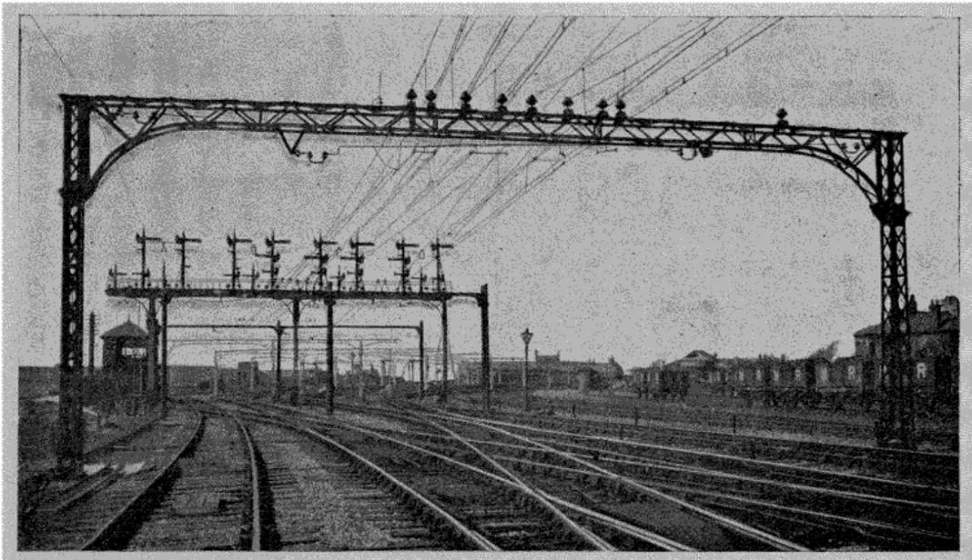
Fig. 13. — Suspension caténaire double : gare de Morecambe.
