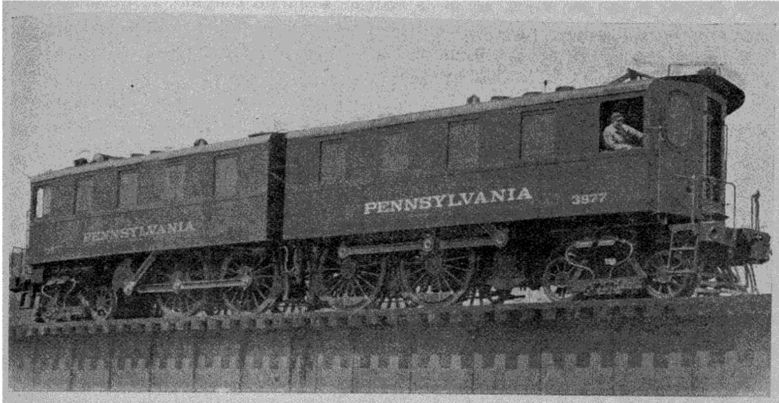
Fig. 47. — Locomotive Westinghouse à courant continu : ligne du Pennsylvania R<sup>d</sup>.
