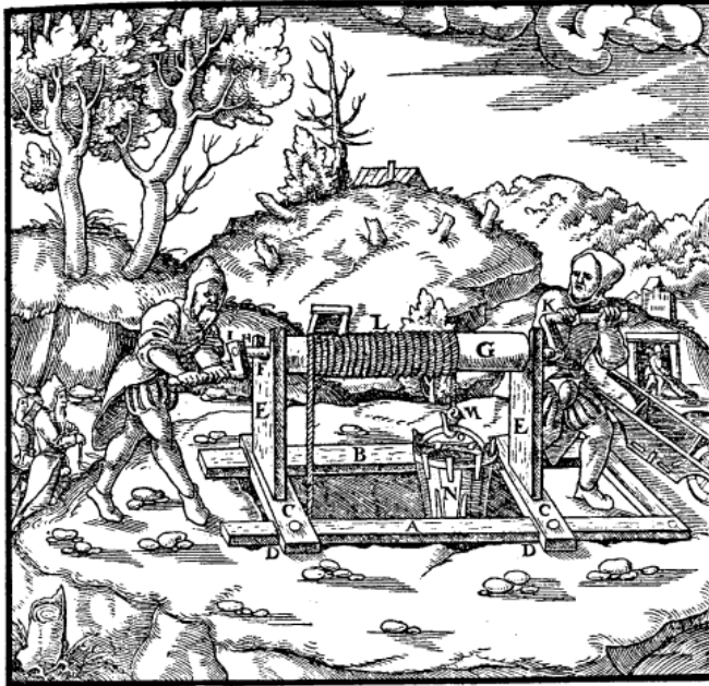
Fig. 15. — Treuil mû par 2 manivelles (Agricola, 1556).
