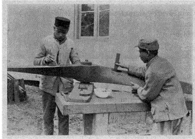
Fig. 6. — Application de la laque sur une hélice aérienne aux Établissements de Chalais-Meudon pendant la guerre.
