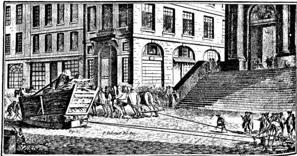
Fig. 46. — Halage d'un traineau par levier funiculaire du deuxième genre, semblable à celui des Esquimaux (figures 29 et 35).
