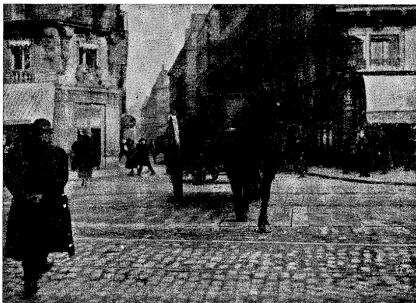
Fig. 9. — Pose, en une nuit, d'un tronçon de caniveau au carrefour Tronchet-Mathurins (5 e phase). 7 h. — La circulation est entièrement rétablie, au moyen d'un platelage destiné à remplacer provisoirement le revêtement de la chaussée.
