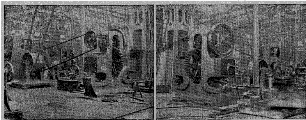
Essais dynamométriques d'une poinçonneuse-cisailleuse, effectués en 1893, dans les ateliers de Batignolles du Chemin de fer de l'Ouest.
