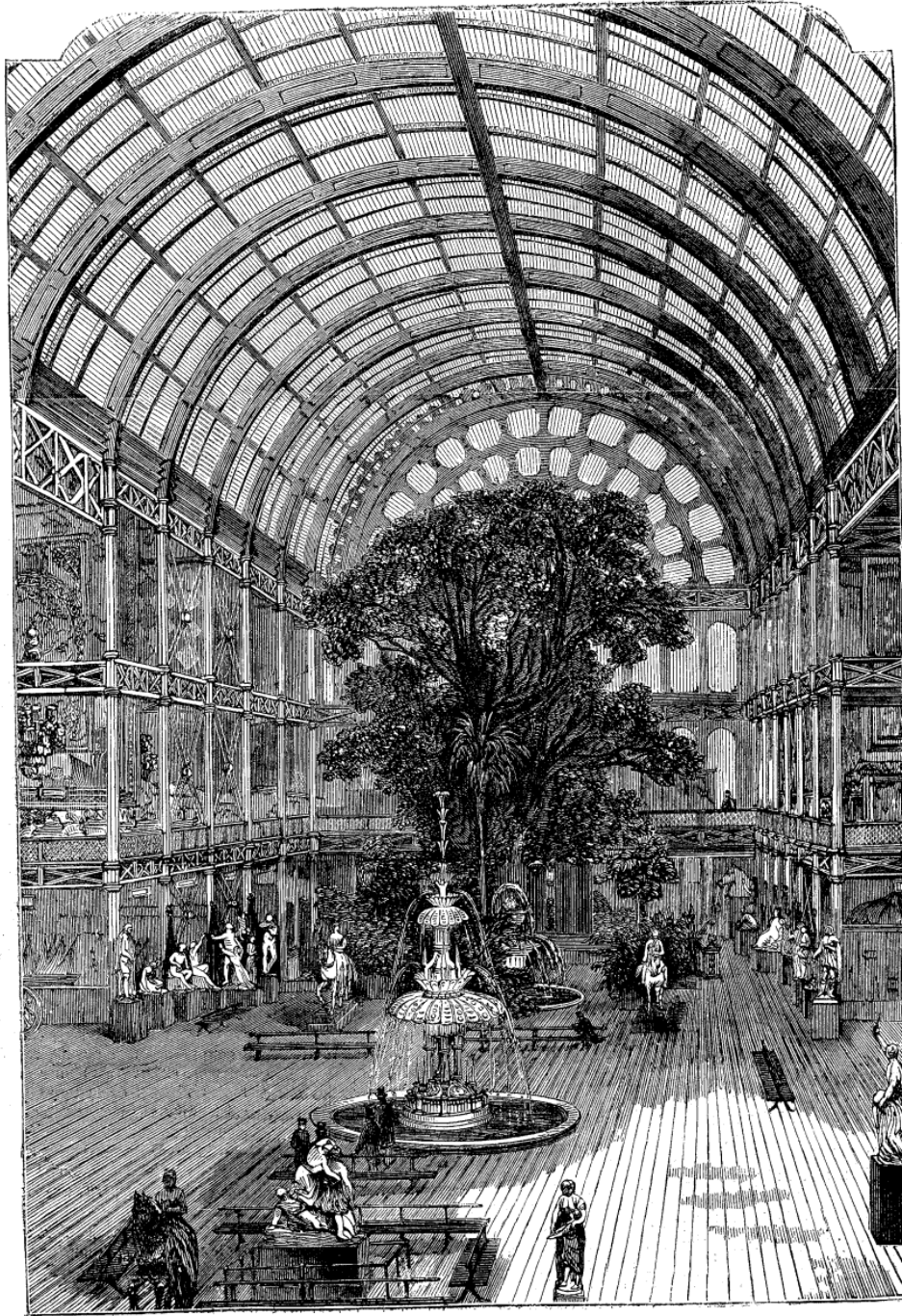
VUE DE L'INTÉRIEUR DU TRANSEPT.
