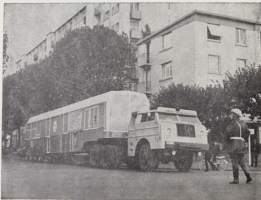
FIG. 16. — La centrale mobile M.38 de 10 000 kW en cours de déplacement sur la route.
