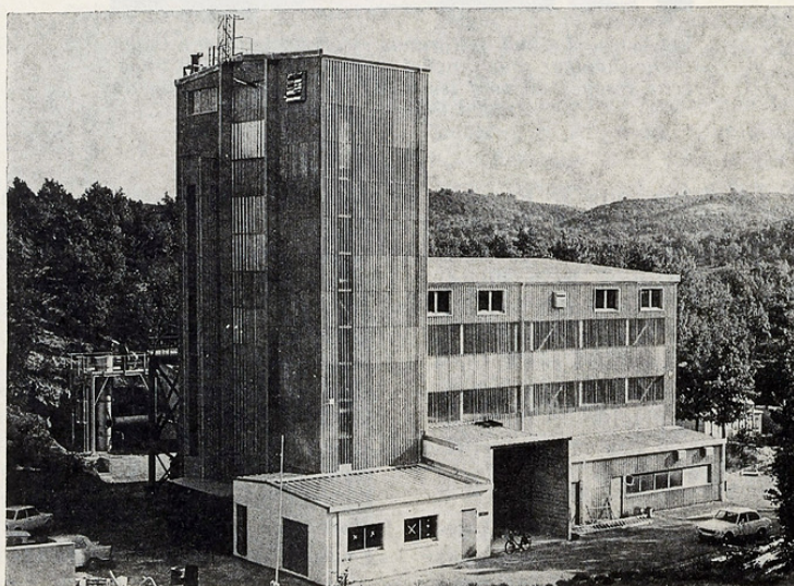
FIG. 36. — Le hall des essais de réaction entre sodium et eau à Cadarache
