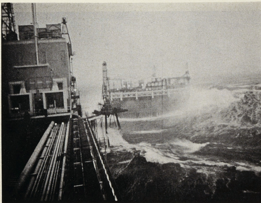
Ekofisk. — Vue du réservoir durant la tempête du 19 novembre 1973.
