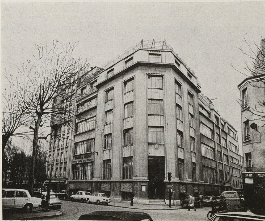
FIG. 2. — Institut de Soudure à Paris (siège).
