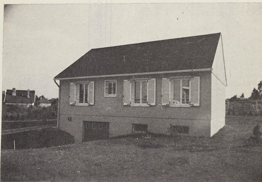
Fig. 3. — Maison témoin identique aux maisons solaires, à part la toiture.
